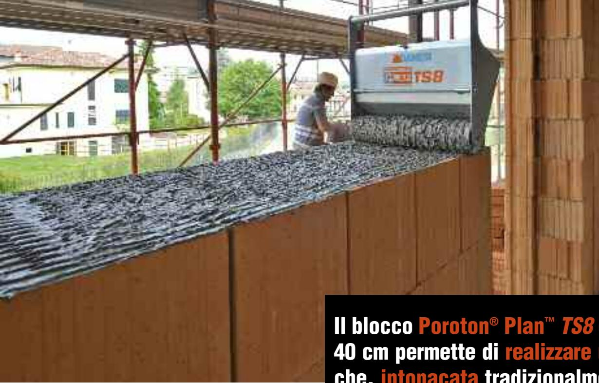
**Il blocco Poroton® Plan™ TS8 con spessore 40 cm permette di realizzare una muratura che, intonacata tradizionalmente, raggiunge una trasmittanza di 0,200 W/m<sup>2</sup>K**
