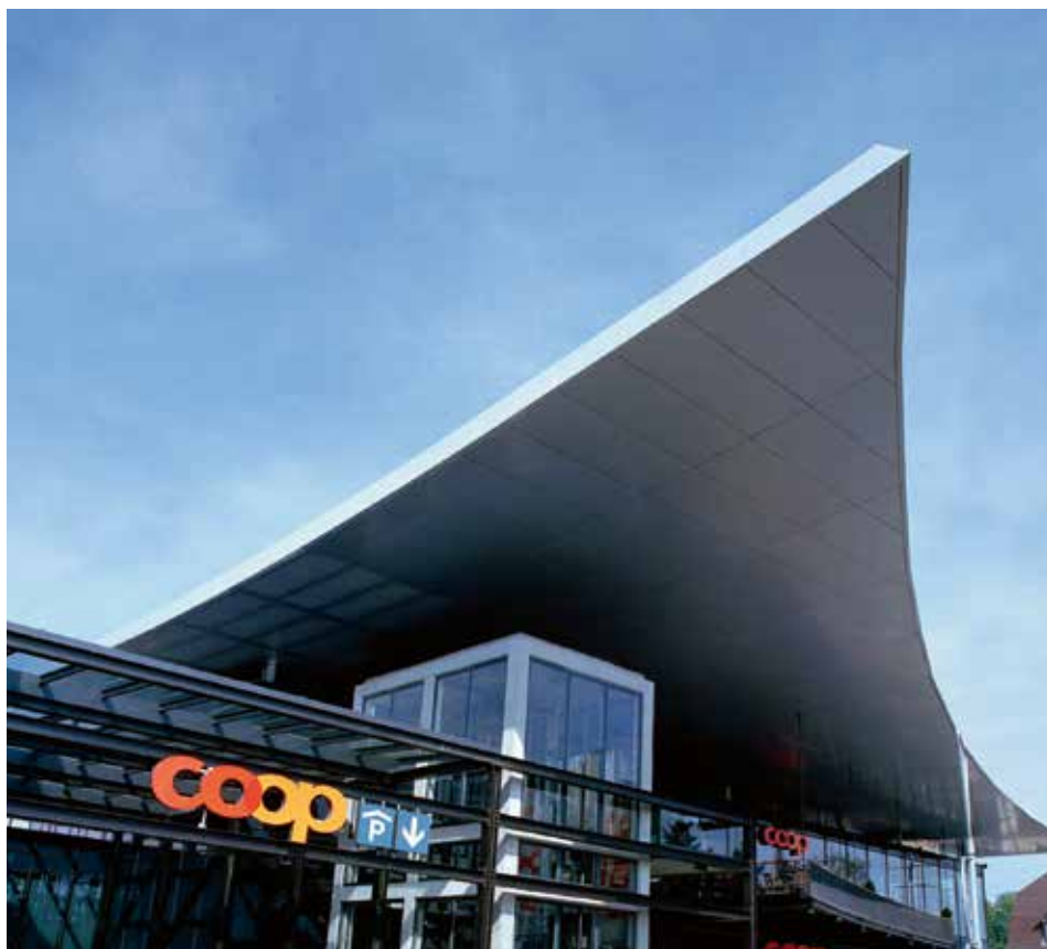
Stabile – grande copertura autoportante realizzata con rivestimento in ALUCORE®
