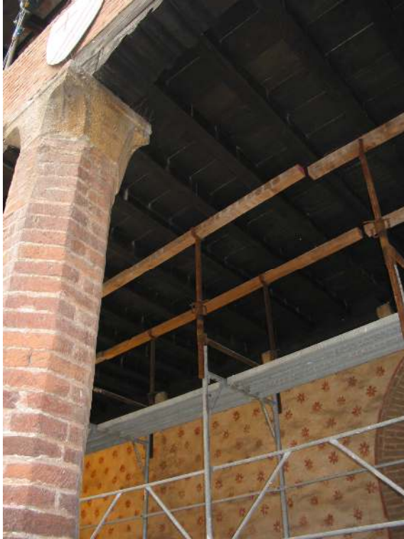
Figura 3 Vista del solaio dal lato inferiore. Molto spesso è necessario puntellare il solaio per tutta la durata della maturazione del calcestruzzo.
