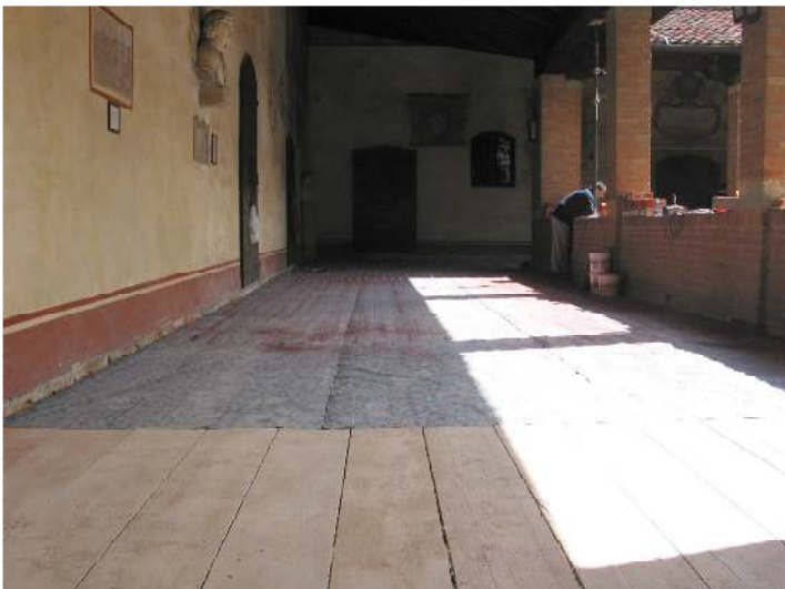
Figura 2 Fase di lavorazione intermedia. Si può notare la stesura di un telo protettivo del tavolato e la preparazione dei fori nella parete.
