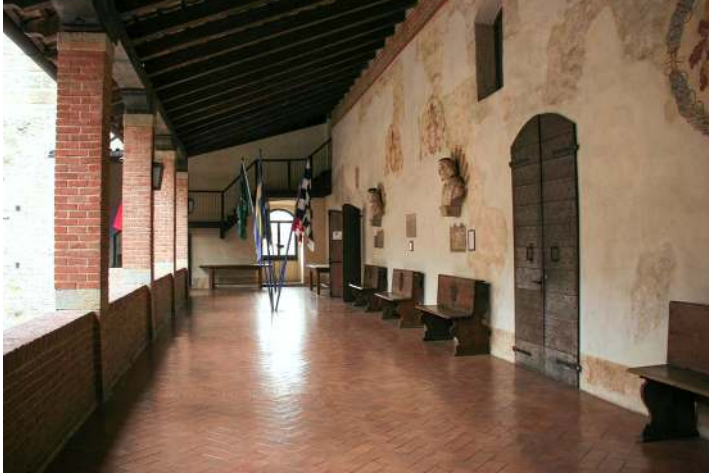
Figura 5 Il solaio allo stato attuale
