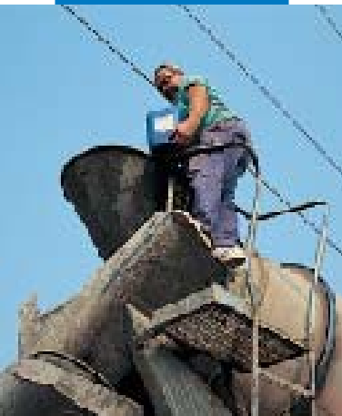
Versamento del Mapeplast LA in autobetoniera
