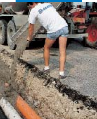
Scarico del calcestruzzo cellulare da riempimento dall'autobetoniera
