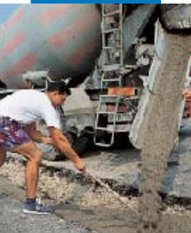
Livellatura del calcestruzzo cellulare da riempimento
