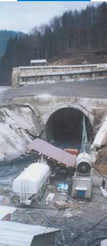
Realizzazione del rivestimento strutturale di prima fase in calcestruzzo proiettato additivato con Mapequick AF1000. Galleria di Trojane - Autostrada Ljubljana-Celje-Maribor, Slovenia
