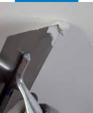
Lisciatura del prodotto con spatola metallica piana
