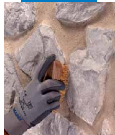
Rifinitura della superficie con spazzola di saggina
