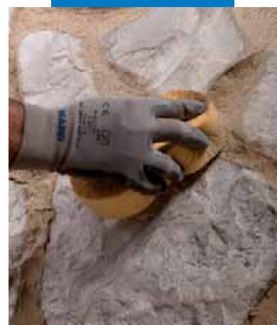
Rifinitura della superficie con spugna
