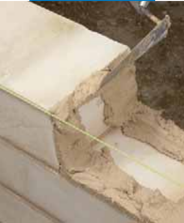
Applicazione di Mape-Antique Allettamento
