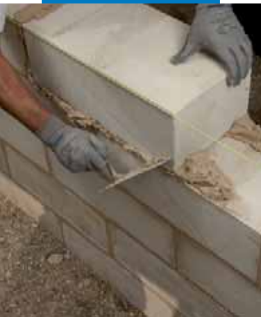
Rimozione della malta in eccesso
