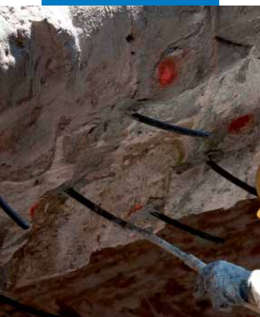
Iniezione di Mape-Antique F21 in una muratura di pietra
