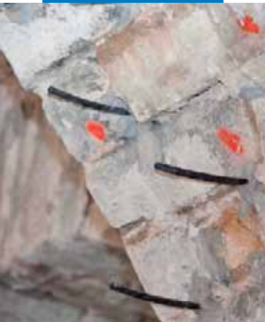
Particolare del fissaggio dei tubicini di iniezione
