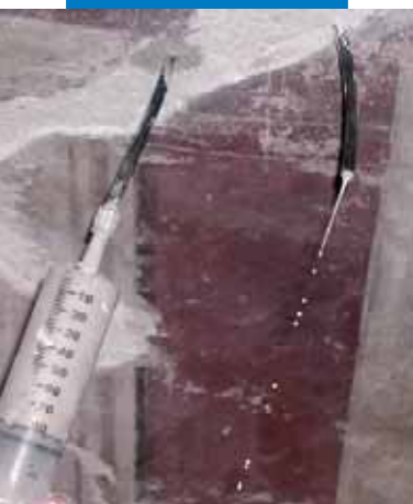
Iniezione di Mape-Antique F21 in presenza di affreschi
