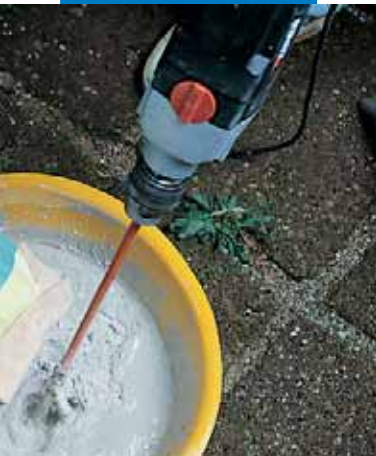
Preparazione di Mape-Antique I
