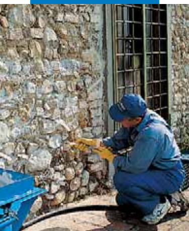
Iniezione di consolidamento con Mape-Antique I
