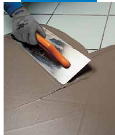
Rasatura di pavimento esistente con Nivorapid
