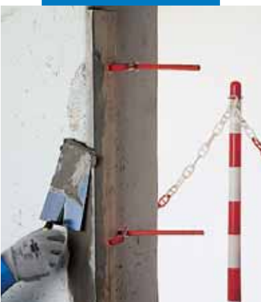
Riparazione di spigolo verticale con Nivorapid
