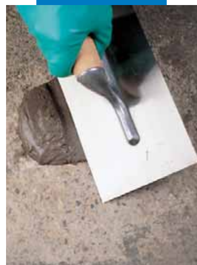
Riparazione di spigolo orizzontale con Nivorapid
