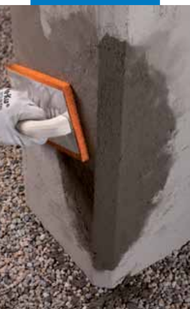
Frattazzatura di Mapegrout LM2K
