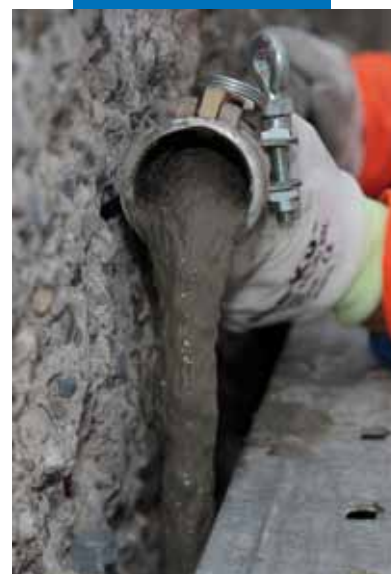
Messa in opera di Mapegrout Colabile GF
