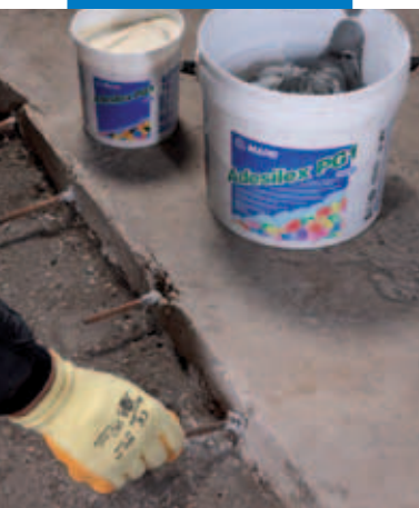
Fissaggio dei ferri per la spinottatura con Adesilex PG1
