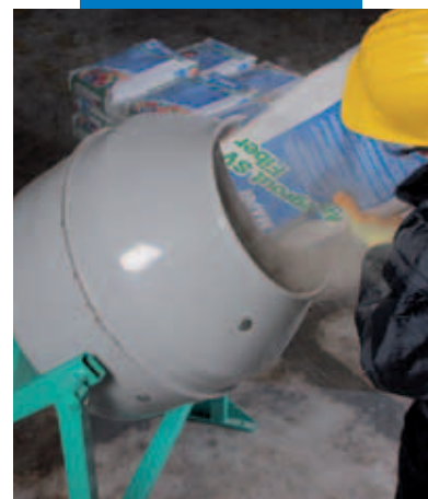
Preparazione dell'impasto di Mapegrout SV Fiber
