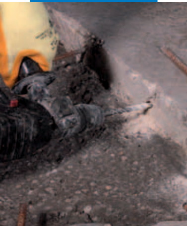
Preparazione dei fori per l'inserimento dei ferri (spinottatura)
