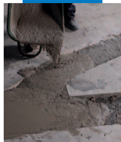
Applicazione di Mapegrout SV Fiber nella zona da ripristinare
