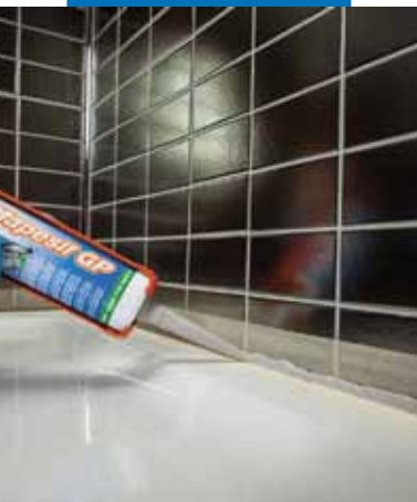
Sigillatura di raccordo tra materiali differenti
