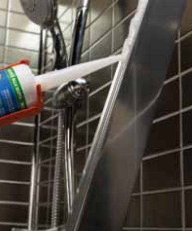
Incollaggio di profili metallici
