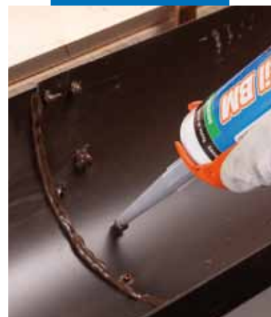
Sigillatura della testa dei rivetti
