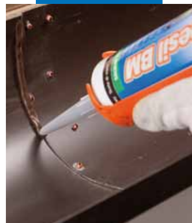
Sigillatura della linea di sormonto
