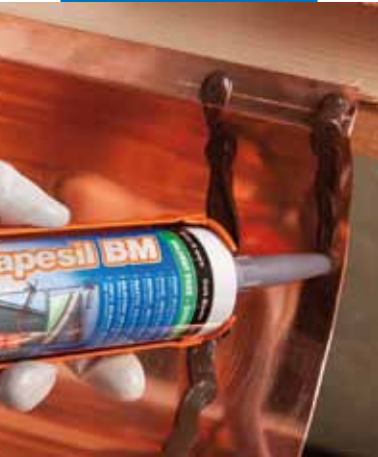
Estrusione Mapesil BM sulla lamiera sottostante prima della sovrapposizione
