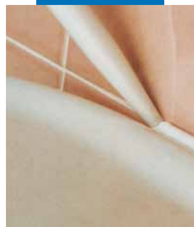
Sigillatura di sanitari
