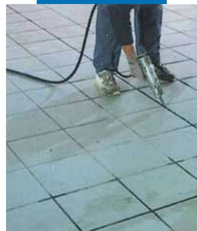
Sigillatura con Mapesil AC di un pavimento di ceramica
