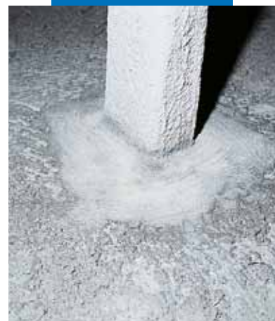
Esempio di pilastro impermeabilizzato con Idrosilex
