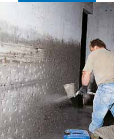
Applicazione a spruzzo del 1° strato di malta additivata con Idrosilex Liquido
