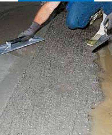
Applicazione del battuto di pavimento additivato con Idrosilex Liquido
