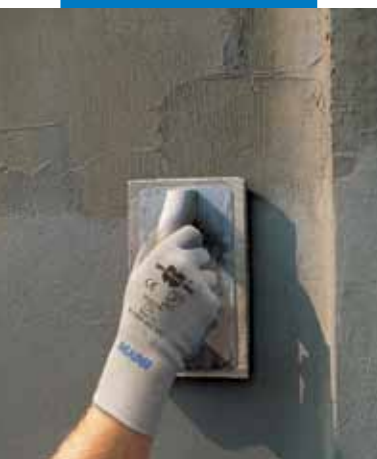
Lisciatura con frattazzo di spugna
