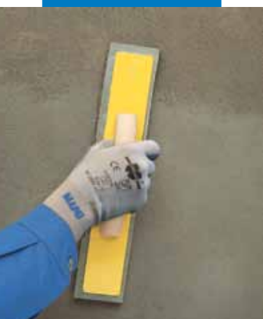
Lisciatura con frattazzino di spugna
