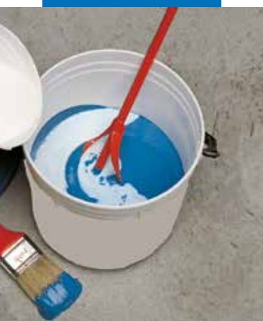
Miscelazione del Mapefer
