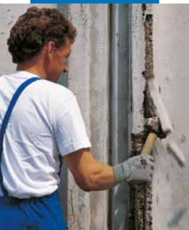
Demolizione del calcestruzzo degradato
