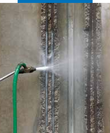
Pulizia dei ferri con idrosabbatura
