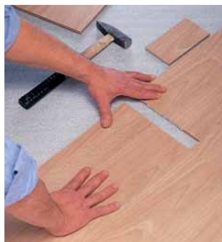
Posizionamento della doga in laminato, maschio, femmina
