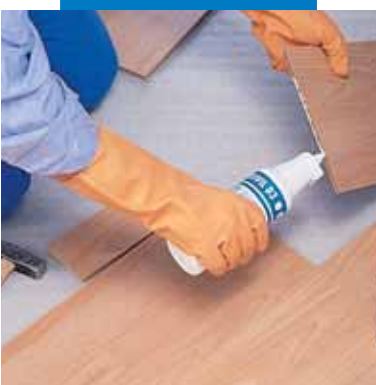
Stesura di Adesivil D3 nella femmina della doga in laminato
