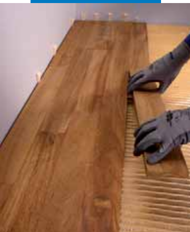
Posa di parquet di grande formato
