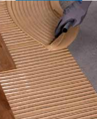
Posa di parquet massiccio su sottofondo in Topcem
