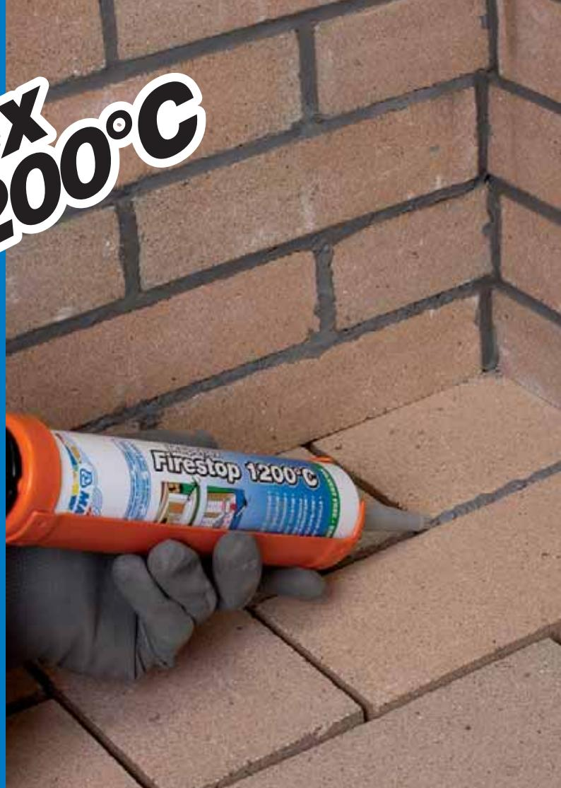
**Mapeflex Firestop 1200°C** è uno stucco rigido ed indeformabile a base di silicato di sodio e particolari cariche minerali, totalmente esente da sostanze tossiche o pericolose, quale l'amianto.
