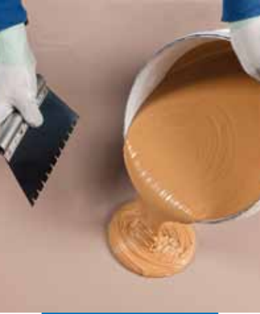
Applicazione dell'adesivo nella zona di posa
