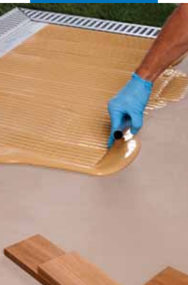
Stesura dell'adesivo con spatola MAPEI per legno in modo uniforme
