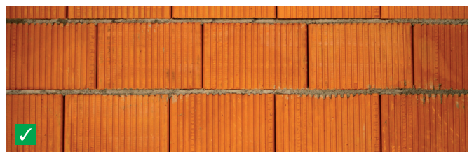
Muratura in mattoni
