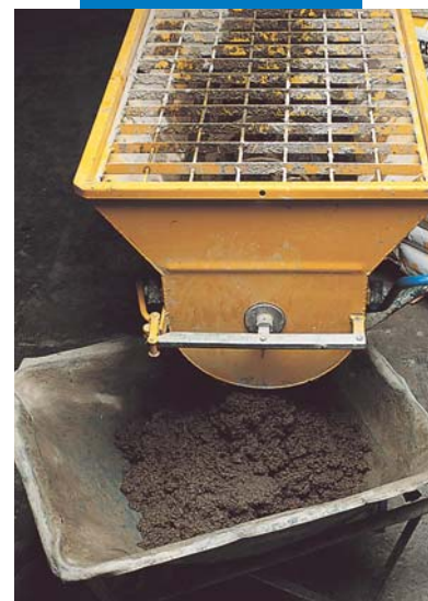
Impasto di Mapecem con minibetoniera
