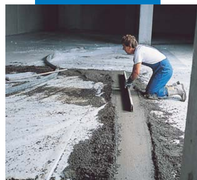
Formazione di fasce di livello
