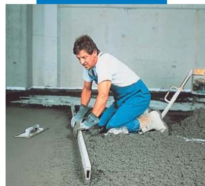
Staggiatura di impasto in Mapecem
