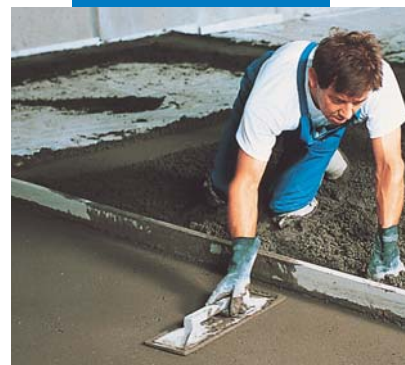
Finitura con frattazzo di impasto in Mapecem
