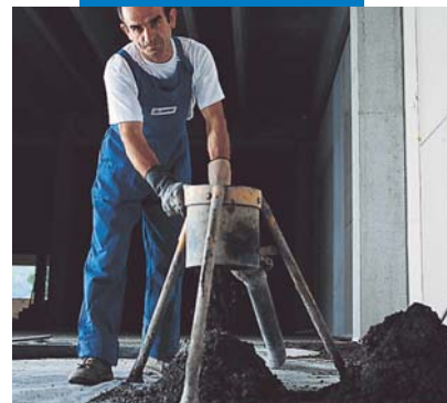
Alimentazione di impasto in Mapecem
