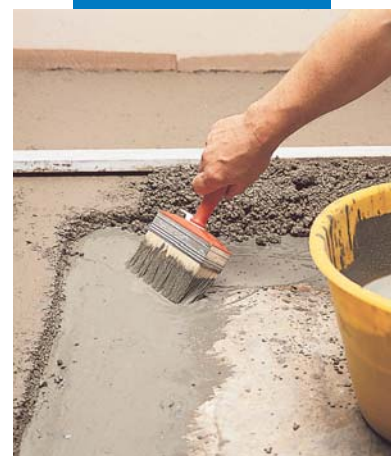
Stesura di boiacca di ancoraggio per massetti in Mapecem aderenti
