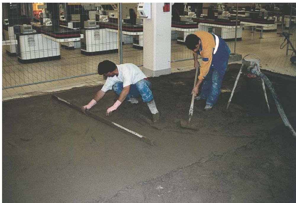
Rifacimento rapido di massetto in un supermercato
