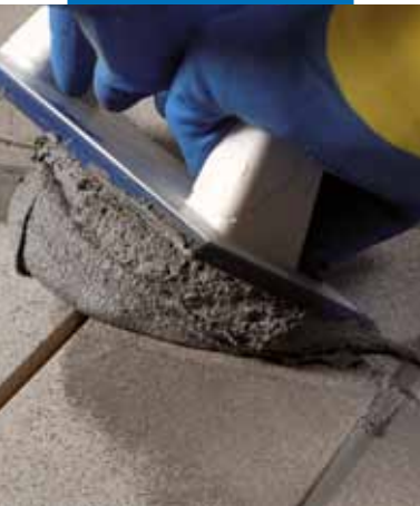
Stesura di Kerapoxy CQ con spatola MAPEI
