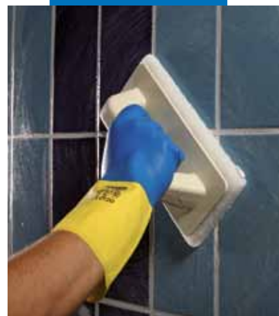
Kerapoxy CQ viene emulsionato con acqua, utilizzando un tampone in Scotch-Brite®
