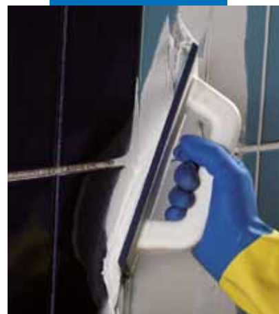
Stesura di Kerapoxy CQ con spatola MAPEI a parete
