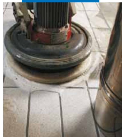
Rimozione di Kerapoxy P con acqua e monospazzola con disco in Scotch-Brite®
