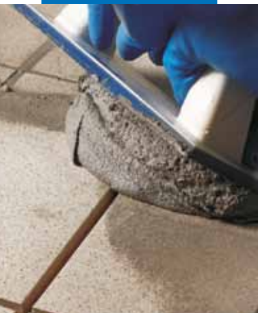
Stuccatura di fughe a pavimento con spatola in gomma
