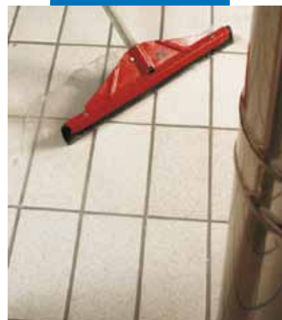
Pulizia della superficie del pavimento con racia di gomma
