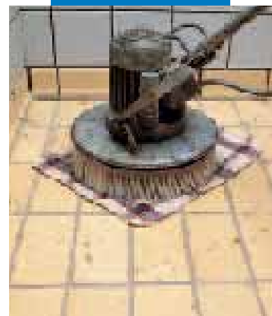
Pulizia con alcool e straccio mediante spazzola rotante
