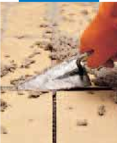
Riempimento della fuga con Kerapoxy SP mediante cazzuolino
