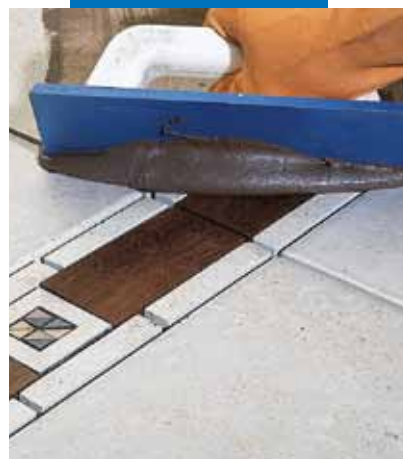
Stuccatura, con spatola, di pavimento ceramico con inserti in legno
