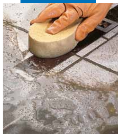
Finitura, con spugna, di pavimento ceramico con inserti in legno
