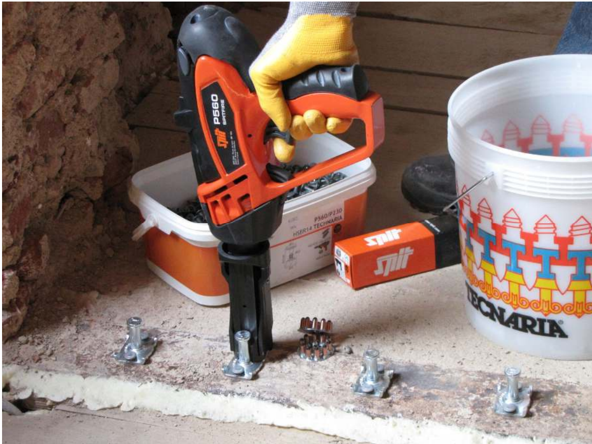
Figura2. La tecnologia dello sparo permette il fissaggio su acciaio esistenti, spesso non saldabili, anche in condizioni di scarsa pulizia del solaio.
