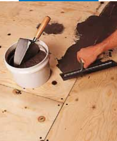
Stuccatura di sottofondo in legno compensato con Nivorapid + Latex Plus
