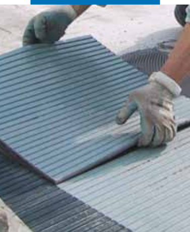
Posa di gomma attacco cemento con Granirapid
