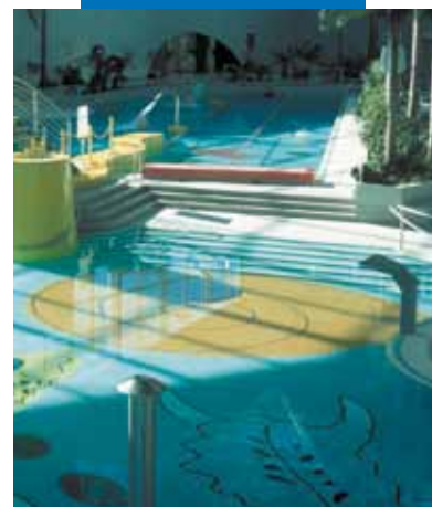
Esempio di posa di mosaico e klinker in piscina
