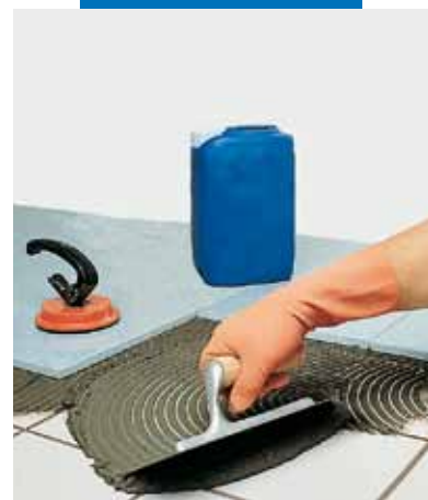
Sovrapposizione di agglomerato su ceramica esistente con Granirapid grigio
