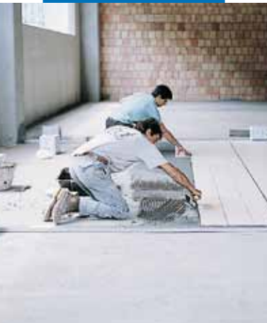
Posa di grès porcellanato in ambiente industriale
