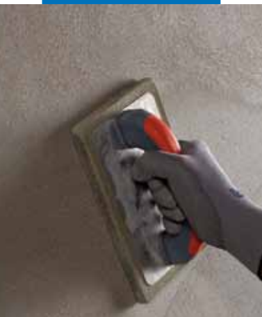
Frattazzatura di Planitop 510
