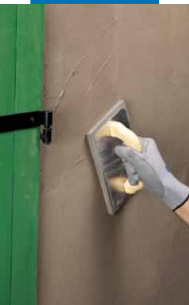
Frattazzatura di Planitop 207
