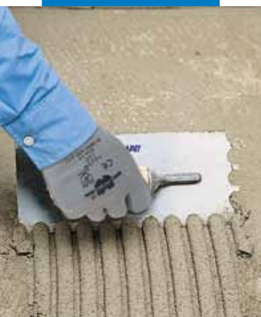
Stesura con spatola a dente semicircolare
