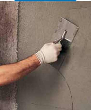
Lisciatura della superficie di Planitop 540 con una spatola metallica
