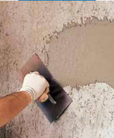
Applicazione di Planitop 540 con spatola metallica
