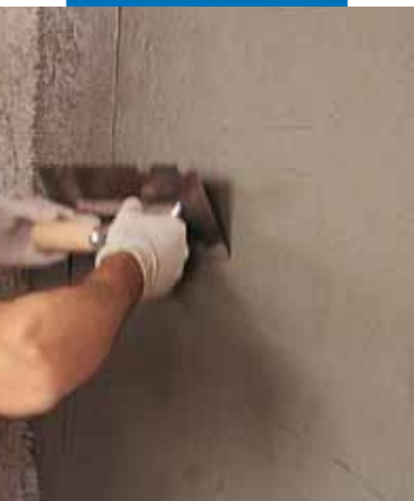
Applicazione di Planitop 540 con spatola metallica
