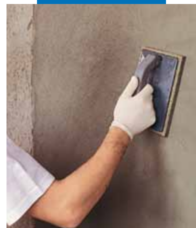
Finitura della superficie di Planitop 540 con frattazzino di spugna
