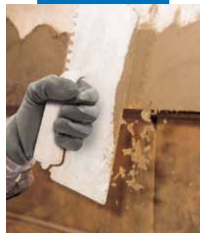
Ripristino di frontalini di balconi: finitura
