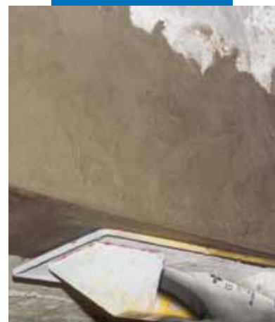
Ripristino localizzato di una trave in calcestruzzo
