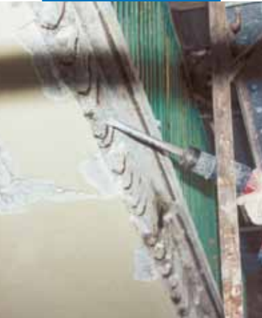
Ripristino di frontalini di balconi: preparazione del supporto
