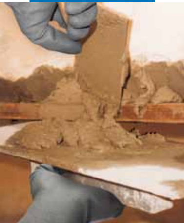
Ripristino di frontalini di balconi: applicazione di Planitop 400
