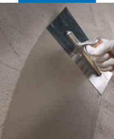
Applicazione di Planitop 200 su calcestruzzo
