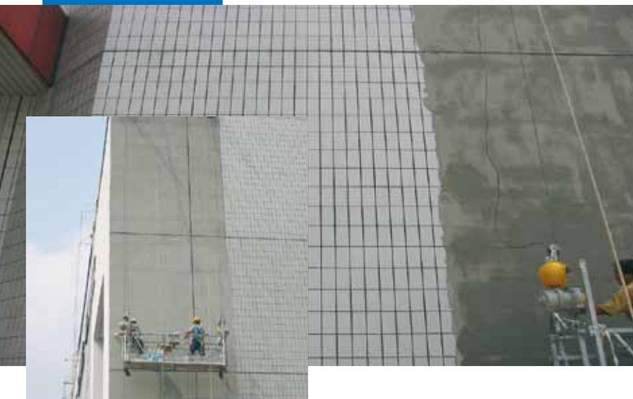
Applicazione di Planitop 200 su rivestimento in ceramica
