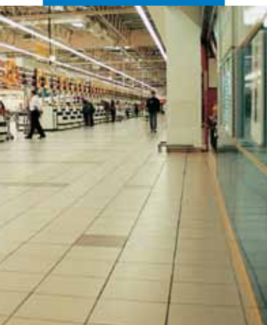
Esempio di posa con Keraquick in un supermercato Auchan - Sosnowiec (Polonia)
