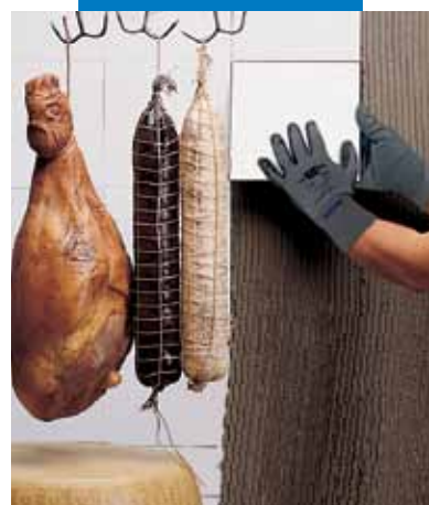
Riparazione di cella frigorifera
