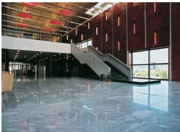
Esempio di posa con Keraquick di posa a pavimento - Hall Casinò Feuchtwangen (Germania)
