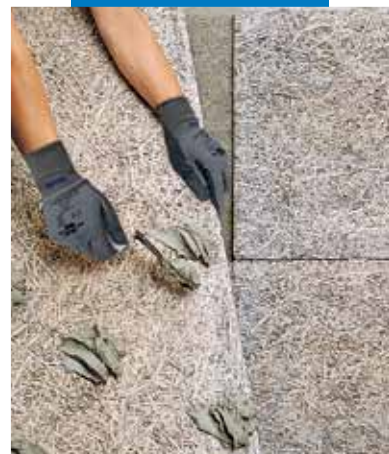
Posa di pannelli isolanti pesanti
