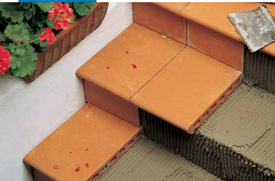
Rifacimento rapido di scala
