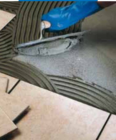
Posa di monocottura a pavimento
