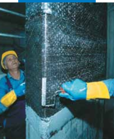
Pressione esercitata sul tessuto con il Rullino per MapeWrap per consentire a MapeWrap 31 di penetrare nel tessuto
