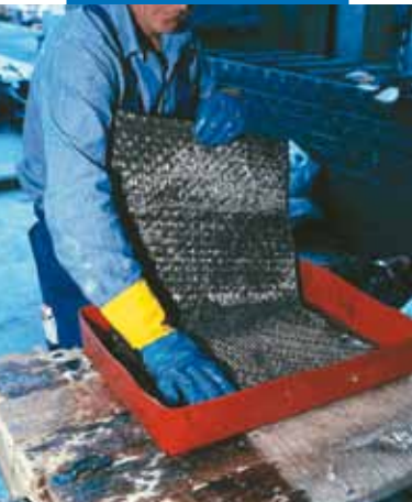
Impregnazione manuale di MapeWrap C
