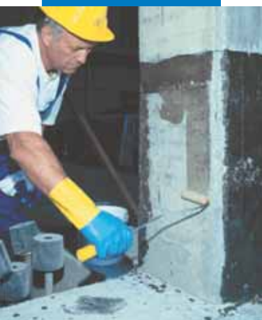
Applicazione della 1ª mano di MapeWrap Primer 1
