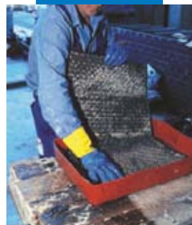
Impregnazione manuale di Mapewrap C
