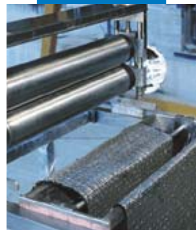
Impregnazione a macchina di Mapewrap C
