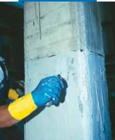
Rasatura con MapeWrap 11 o MapeWrap 12
