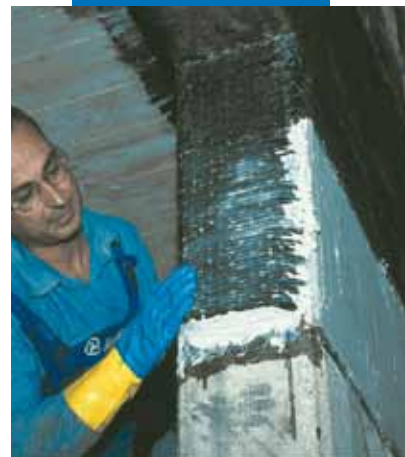
Fasciatura di pilastri e travi
