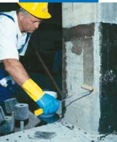
Applicazione di MapeWrap Primer 1
