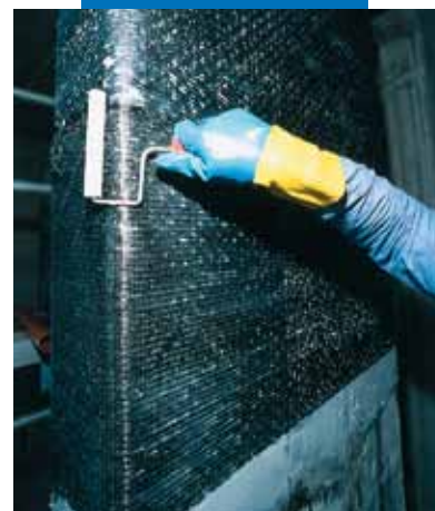
Applicazione della seconda mano di MapeWrap 31
