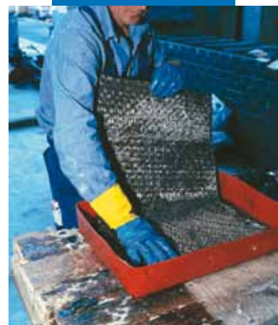
Impregnazione manuale di MapeWrap C
