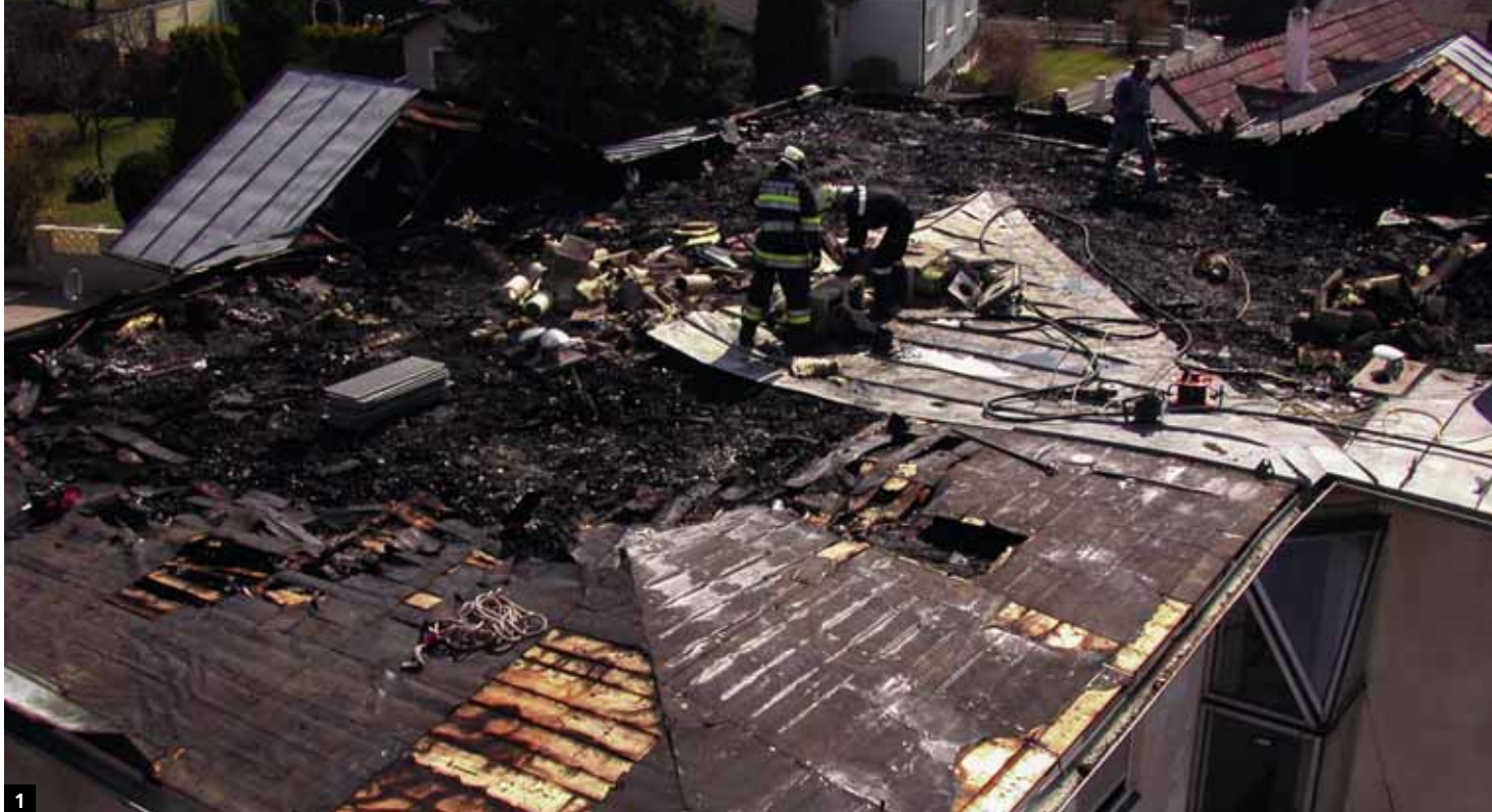
1 La propagazione del fuoco attraverso il tetto è spesso causa di danni catastrofici
