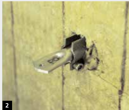
2 Ancoraggio posato a regola d'arte
