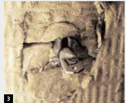
3 Ancoraggio posato in cantiere
