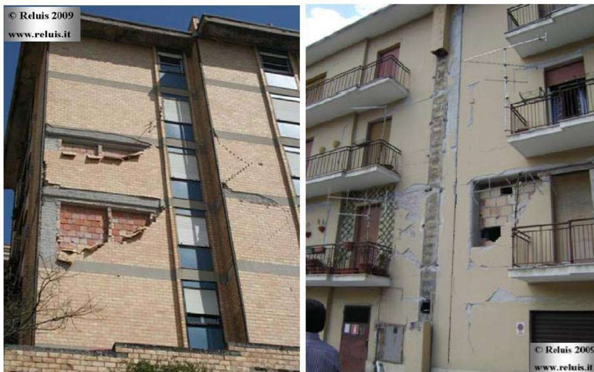
Danni alle tamponature di strutture in c.a.: crolli parziali della fodera esterna (di I. Iervolino, A. Prota, P. Ricci, G. M. Verderame).
