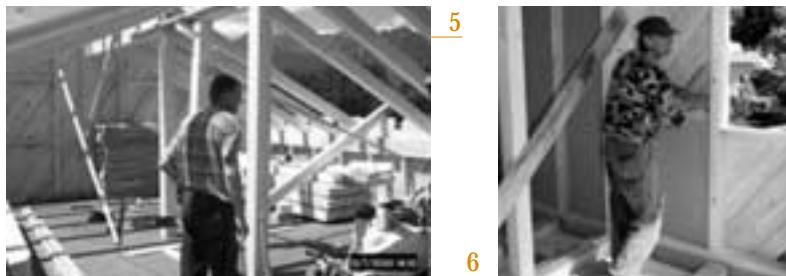
Dopo aver montato anche il tetto (foto 5), possono iniziare i lavori all'interno della struttura. Per prima cosa, vengono coibentate le pareti perimetrali (in questo caso, con pannelli in fibra di legno di spessore totale di 12 cm), formando un involucro ad altissimo livello
