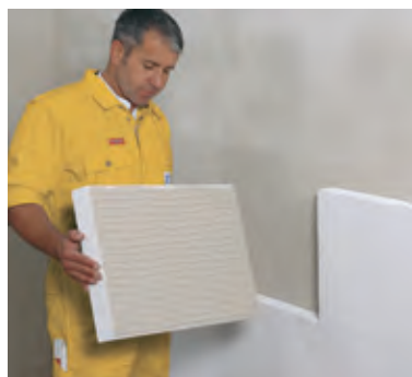
Quindi è sufficiente appoggiare il pannello Ytong Multipor sulla parete, ed intonacarlo o rasarlo.
