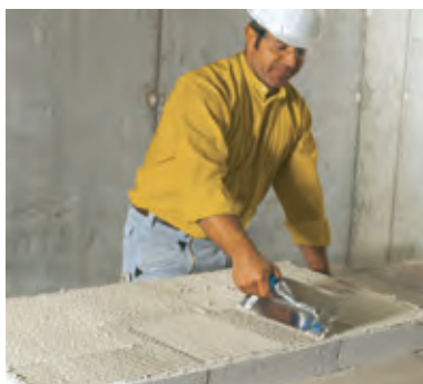
La malta leggera viene applicata sui pannelli con la spatola dentata.
